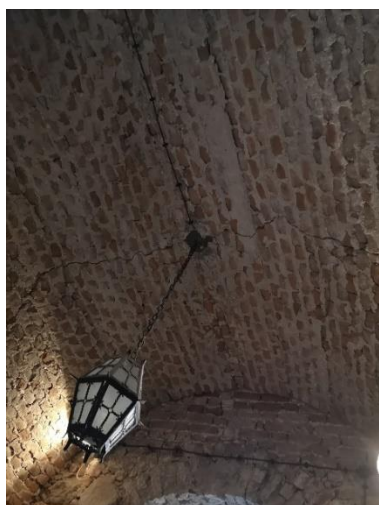
Miejsce montażu oświetlenia szynowego (wokół istniejącej lampy).
